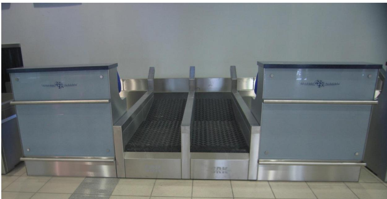
Практически бесшумные конвейеры линии регистрации имеют современный внешний вид (ограждения и обрамления из нержавеющей стали) и могут быть интегрированы в любую дизайнерскую концепцию аэропортового терминала.
